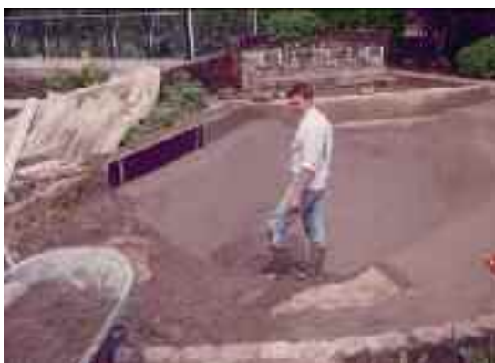
Pose du stabilisé.
