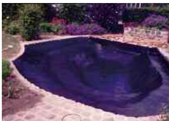
Pose de l'enduit
