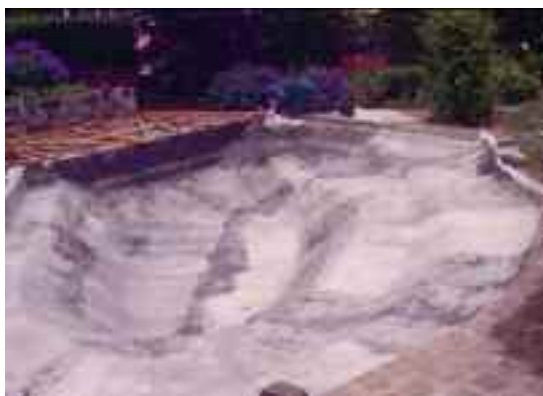
Le travail terminé
